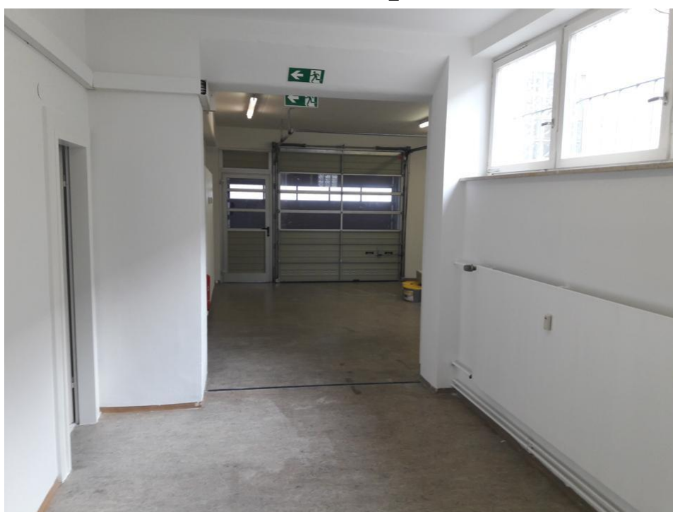
EG Blick von Rolltor und Freifläche 20180307_092834
